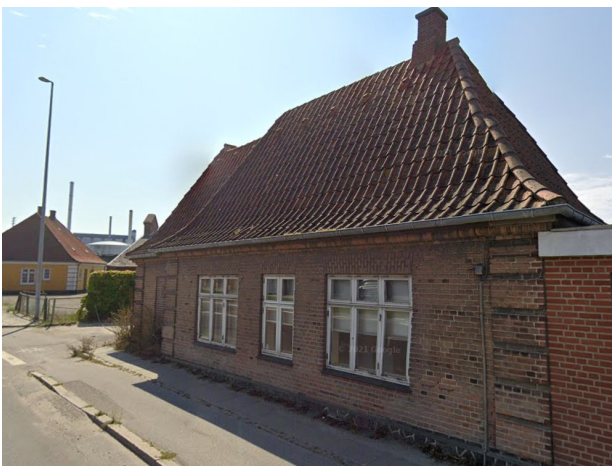
Betonværkets administrationsbygning (1928), sikres med bevarende bestemmelser og indgår i erhvervsbyggefeltet.
