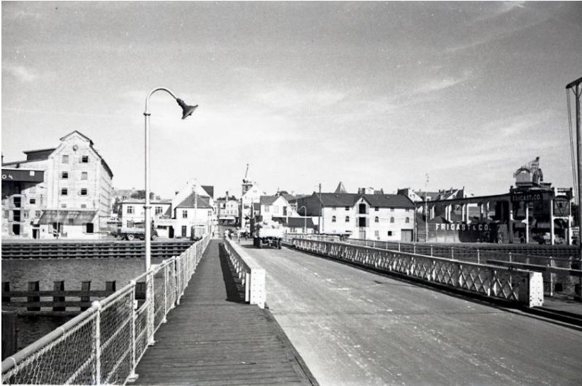
Billedet er taget af svingbroen efter 1933. Kørebanen blev udvidet og der blev placeret ophøjede fortov på hver side af det inderste rækværk. Det yderste rækværk blev trukket ud sammen med fortovet. Kilde: Falsters Egnshistoriske Arkiv. 057-1991_023. Fotograf J. F. Jessen.
