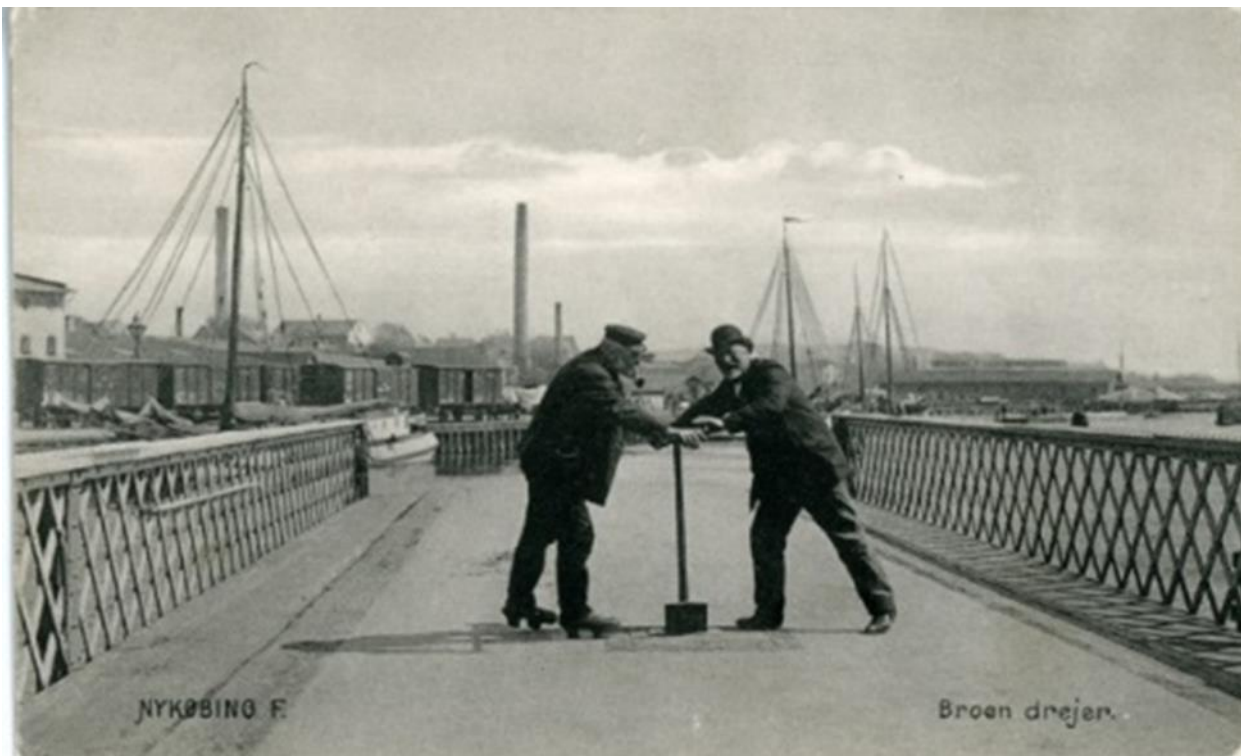
Svingbroen på Christian d. 9's bro bliver drejet med håndkraft før 1910.
